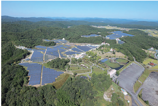
図10 大容量シリコン太陽電池の設備例 (広島県安芸高田市某発電所) 出典：(株)ウエストホールディングス
