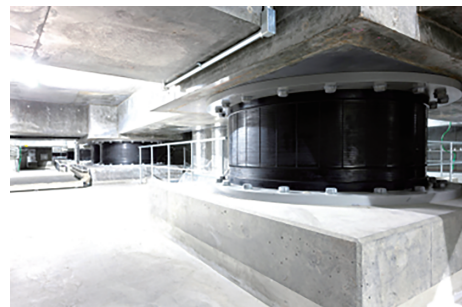
図11 積層ゴム支承の例
