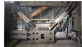
b) シアリンク型制振ユニット
