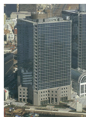
a) シーバンスS館制振改修 (1991年竣工、2012年改修)
