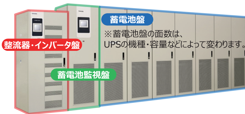
図3 UPSシステムの構成例
