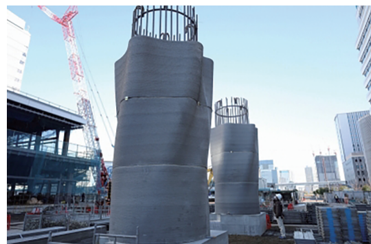
写真17 3Dプリンティング型枠で構築した柱部材
