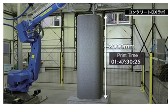
写真15 埋設型枠の3Dプリンティング状況
