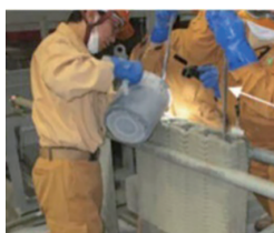
写真4 超高強度繊維補強コンクリートの充填
