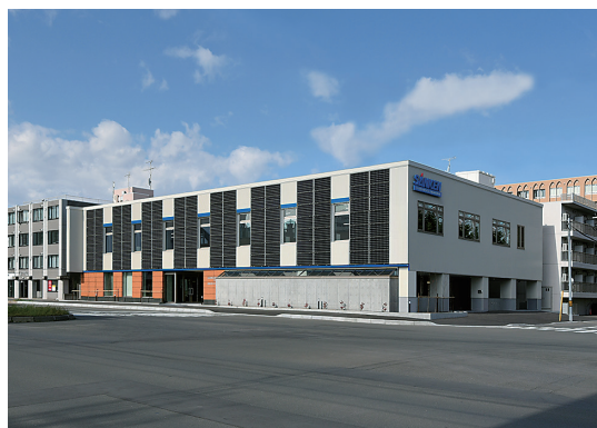
写真4 外壁に設置された太陽光発電パネル
