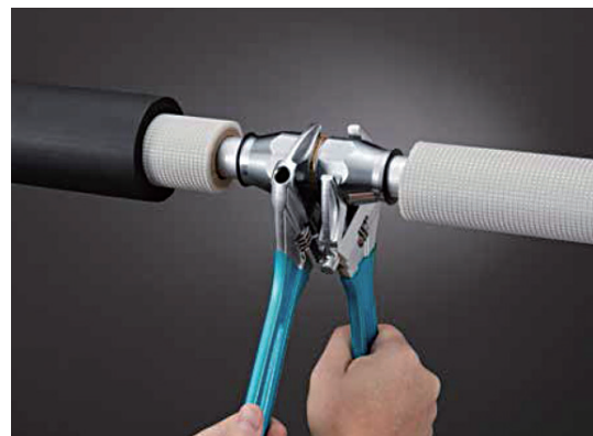
図9 袋ナット継手方式による施工状況
