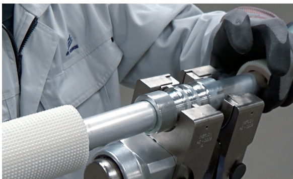
図7 かしめ継手方式による施工状況
