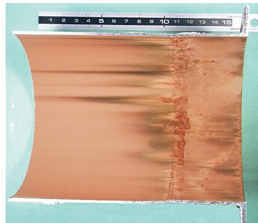
写真3 ステンレス鋼管 (SUS304) 溶接部の腐食 (7年使用)
