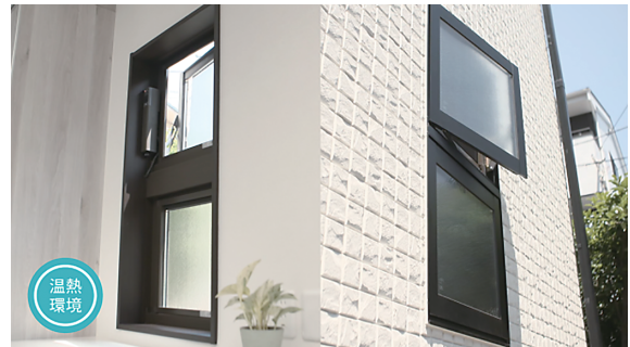
写真4 開口部の自動開閉システム
