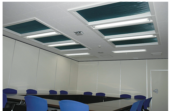
写真2 パッシブチルドビーム設置例
