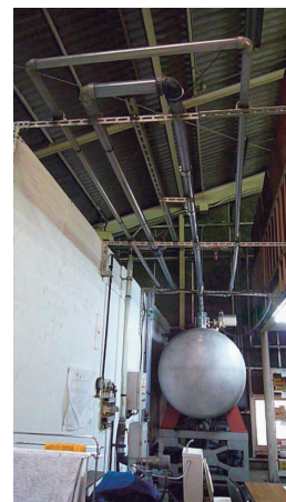
図5 真空集水管路
