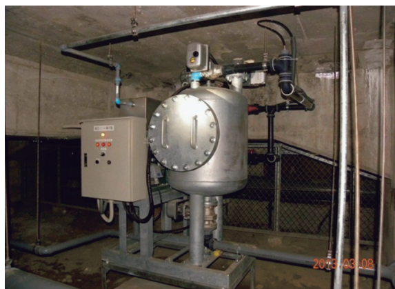
図7 海浜幕張駅舎改札階下の真空ユニット設置状況
