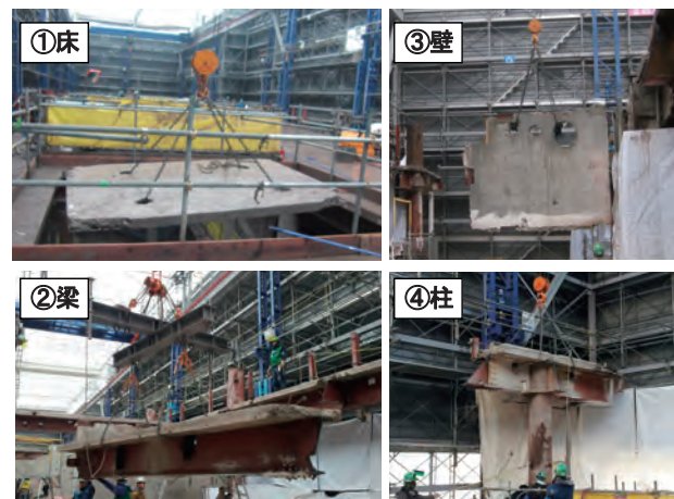
ハット内部のブロック解体状況
