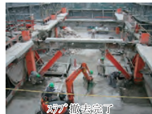
スラブ撤去完了
