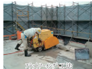
フラットソーイング工法
