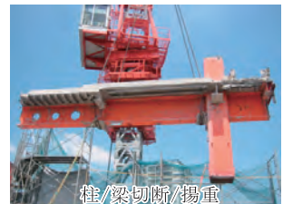
柱/梁切断/揚重
