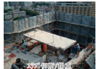
スラブ切断/揚重
