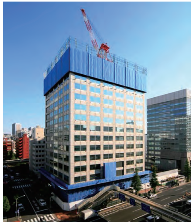
全景及びスライドユニット足場
