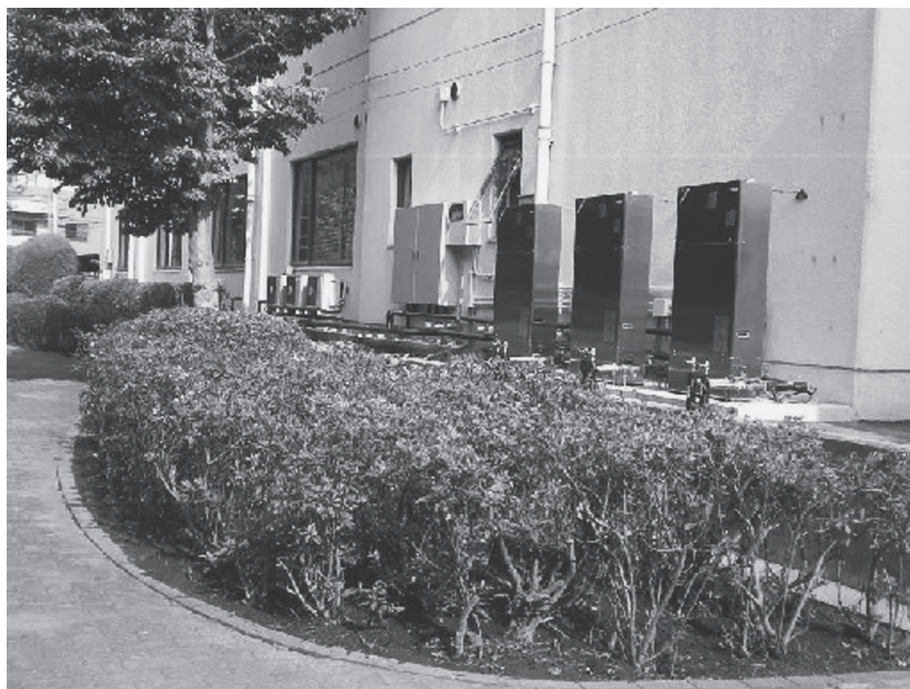
【図4 ヒートポンプ設置状況】
