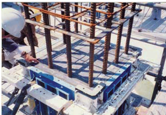
施工状況写真(2) ゴムマット養生
