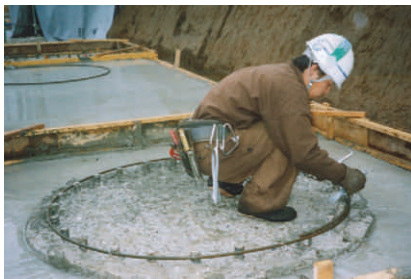
(a) 追加フープ巻き付け
