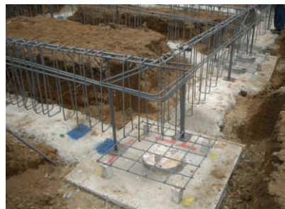
(b) 基礎の配筋状況
