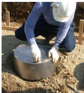
(a) FT キャップの設置
