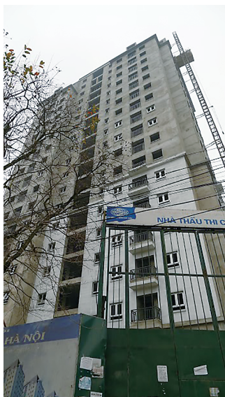
写真2 ハノイ旧市街地の 高層住宅建設現場
