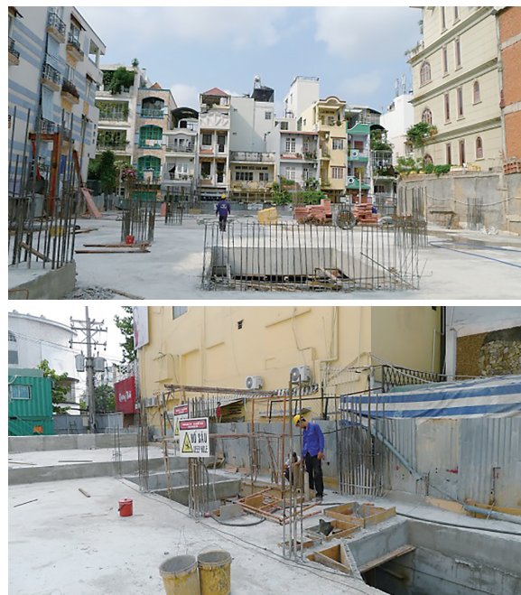
写真1 ホーチミン市街地の建設現場
