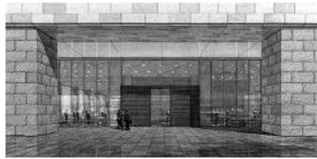
図8 東側エントランス
