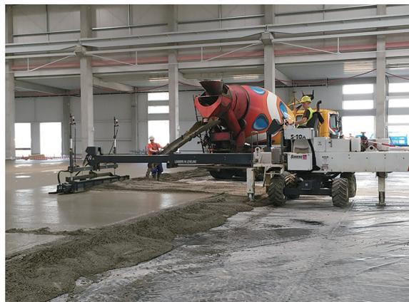
写真5 自動床均し工事で用いられる大型の建設機械
