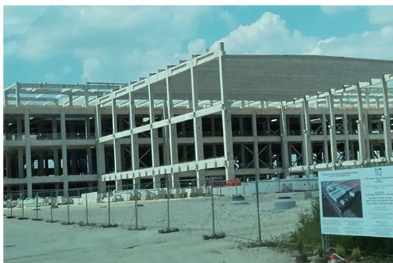
写真4 ブダペスト郊外でのPCa造の工事現場
