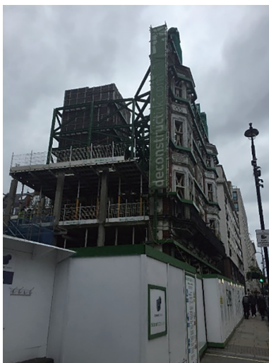
写真1 保存建物西側から見た内部の再開発状況
