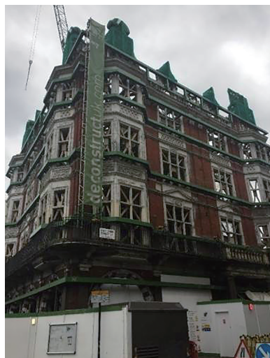
写真2 保存建物東側の外壁補修状況
