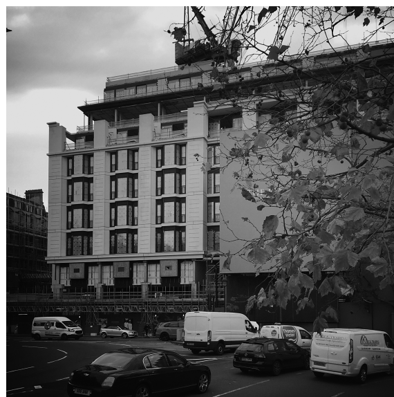
写真1 ザ・ベニンシュラ・ロンドン（施工中、2020年筆者撮影）
