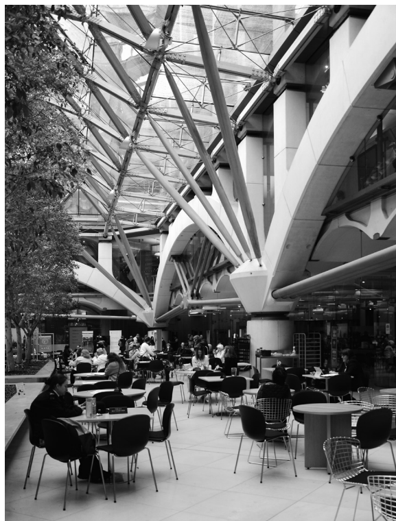
写真2 ポートカリス・ハウス、コンクリート躯体（2018年筆者撮影）
