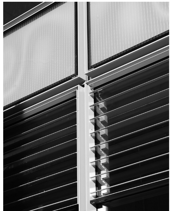
写真3 ハックニーサービスセンター、カーテンウォールのディテール (2008年筆者撮影)
