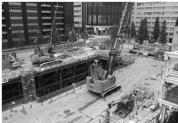
写真5 (仮称) 大手町1-1計画A棟新築工事現場
