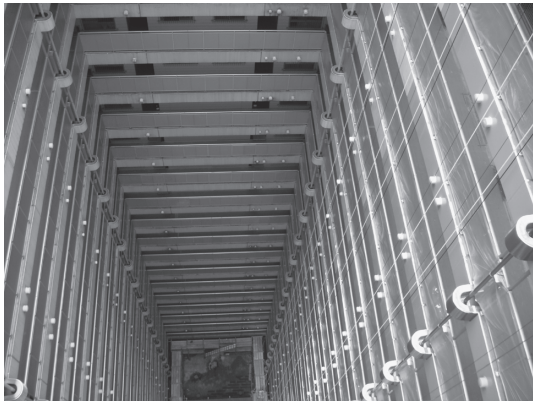
写真2 内側の吹き抜け部分の仮設
