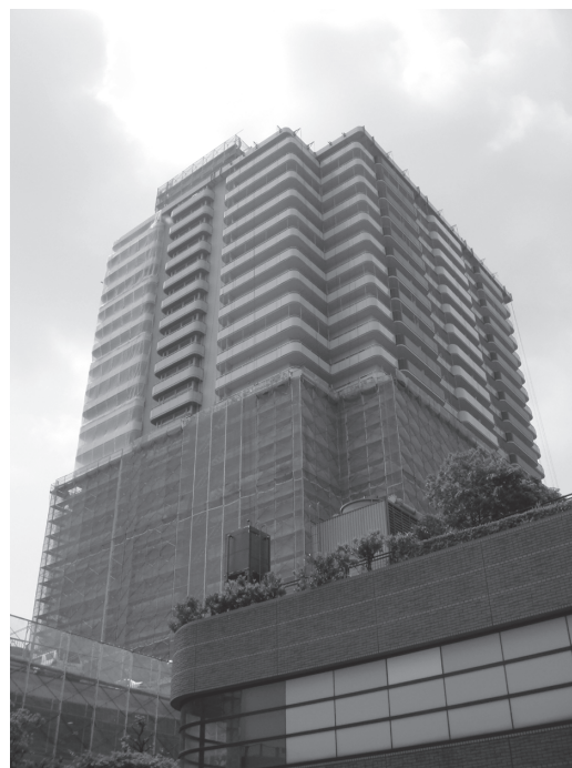
写真1 改修工事における「枠組み足場とゴンドラ足場の併用事例」
