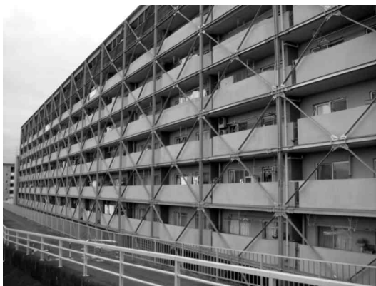
写真1 豊栄綱島マンション
